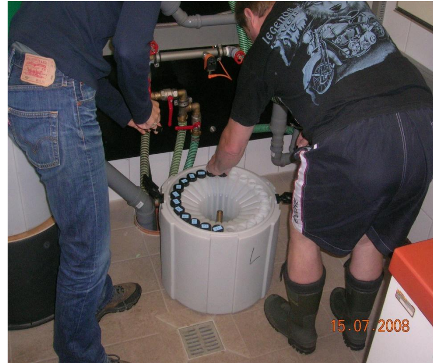
Installation automatischer Probenehmer an den Zuflüssen der Talsperren Klingenberg (links) und Lehmühle (rechts)
