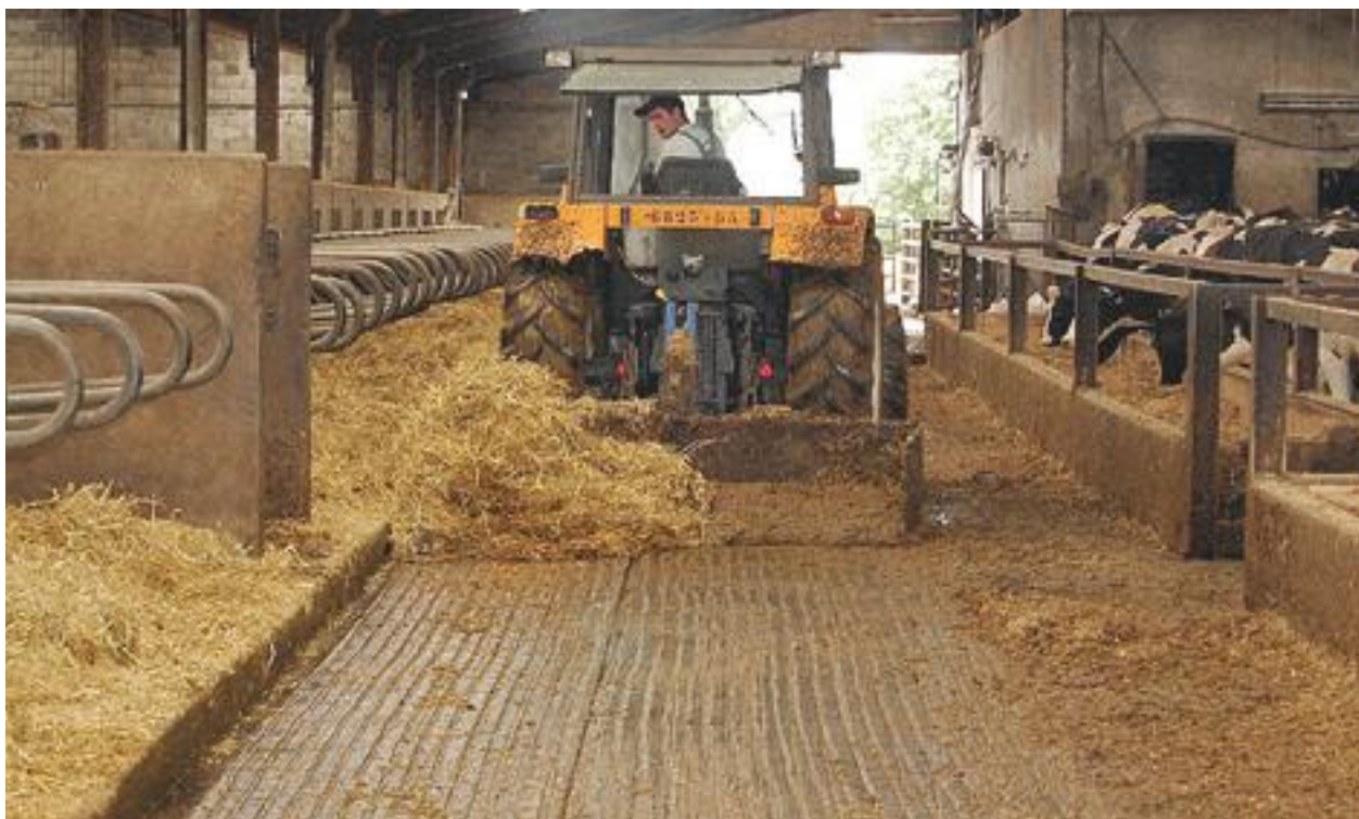
Fotografia 4.9. Szorstka, ryflowana powierzchnia podłogi (fot. J.L. Jugowar)
