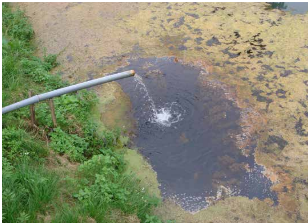
Fot. 12. Zakwit glonów w zbiorniku retencyjnym
