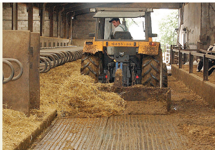
Fot. 2. Szorstka, ryflowana powierzchnia podłogi
