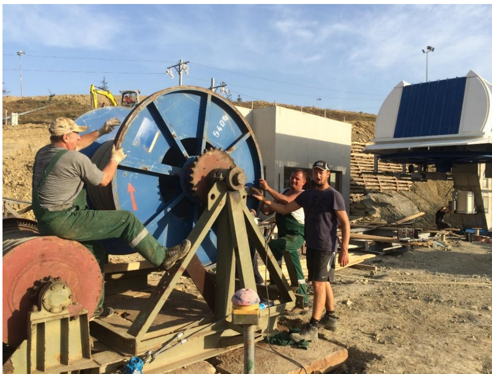
Ryc. 45. Budowa wyciągu narciarskiego Master-Ski.
